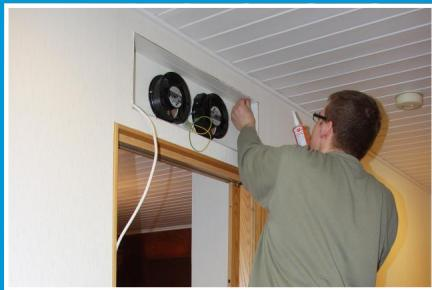
Efter att utrustningen är installerad i öppningen så tätas mellanrummet mellan väggelementet och genomföringskanalen. Luftriktening skall vara mot det rum som skall värmas / avkylas.
