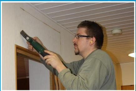
Oven yläpuolelle tehdään 550 × 215 mm kokoinen aukko. Sen voi tehdä myös muualle kuin oven yläpuolelle, mutta mielellään seinän yläosaan.
