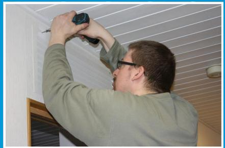
Säleiköt kiinnitetään paikoilleen ja asennus on valmis. Säleikkö asennetaan siten että ilmavirtaus on kattoon pään.
